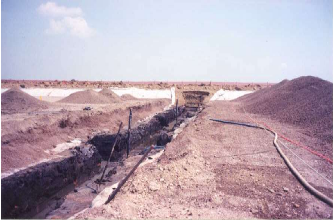
Particolare di una sezione durante i lavori
