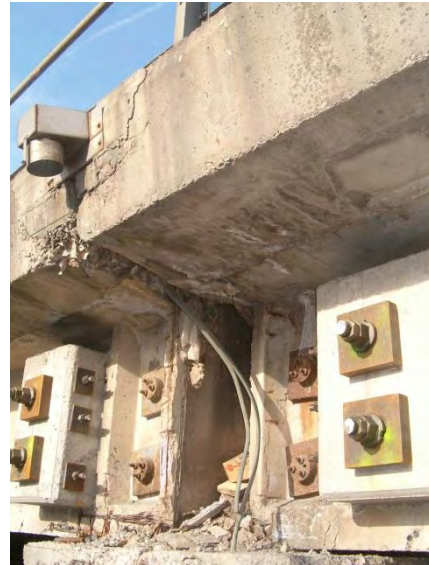
Ubicazione dell'estensimetro per la misura delle deformazioni in mezzeria della trave di bordo
