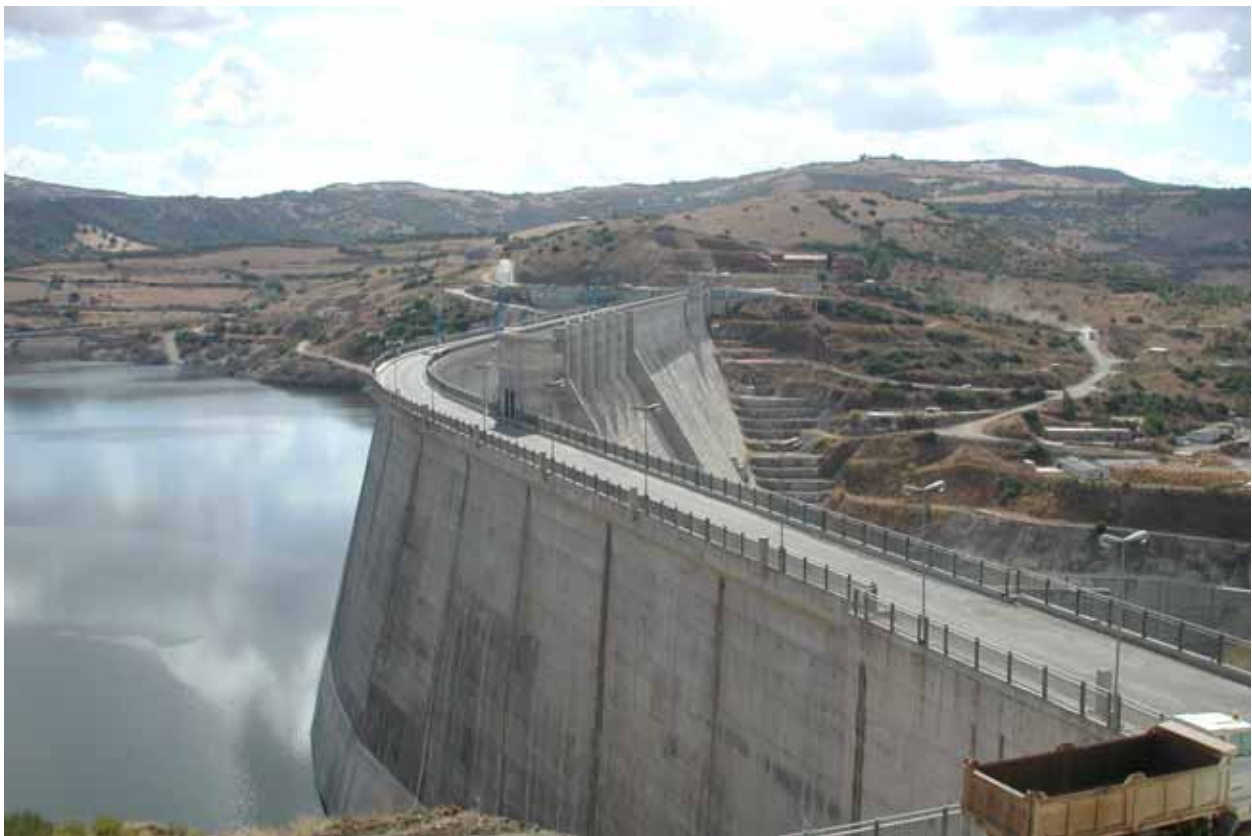
Figura 1: Diga Cantoniera sul fiume Tisro
