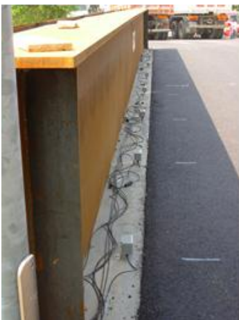
Fig. 1 – Elettrolivelle lungo un ponte durante una campagna di prove
