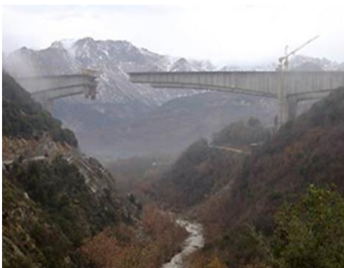
Fig. 18 – Ponte a mensola libera durante le fasi di incrocio sezioni
