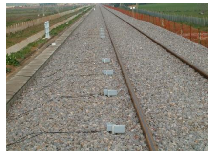
Fig. 2 – Elettrolivelle su traversine ferroviarie
