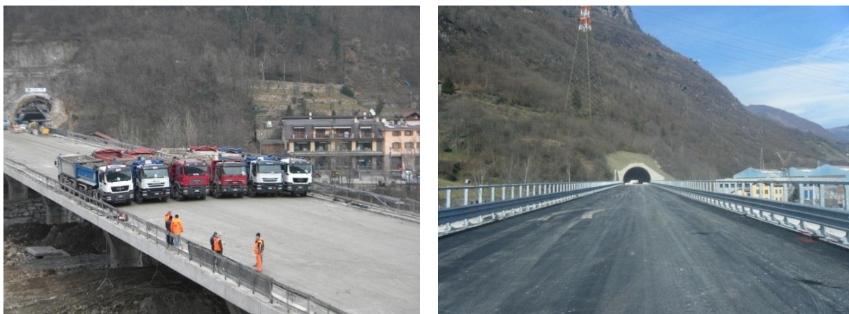
Fig. 9-10 – Viadotto Sellero durante una prova di carico
